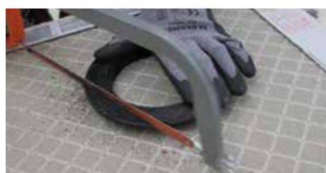
4. Girar la base y retirar uno de los lados a lo largo de la línea precortada.
