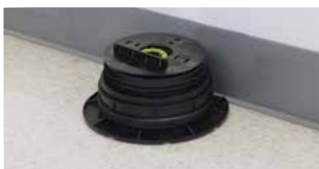
18. Assembler le support et le placer avec le côté découpé appuyé contre le mur.
