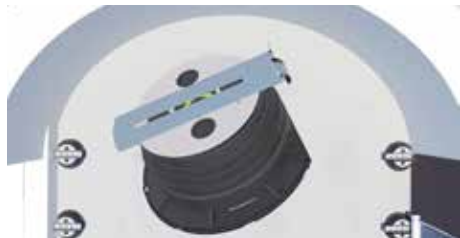
7. Placer la cale SUPACLPP perpendiculairement au mur.
