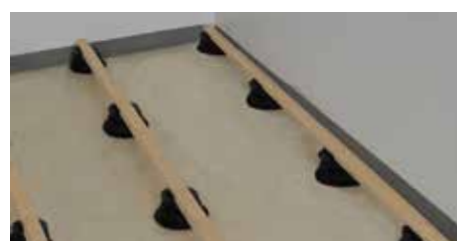
21. Vérifier que le liteau est fixé solidement sur chacun des supports.
