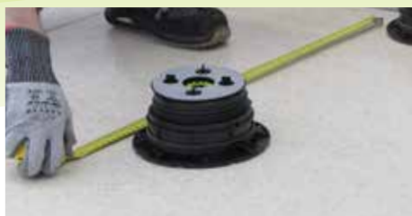
12. Aleje el centro del soporte en proporción a la dimensión de la baldosa. Distancia máxima: 60 cm
