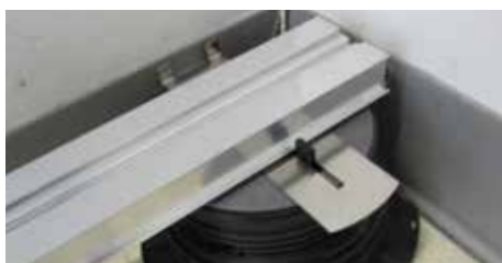
7. Encajar el rastrel entre las aletas SUPA4 del soporte esquinero.
