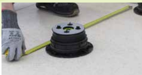
12. Positionnez les plots, laissant, entre le centre du premier plot et les suivants, un espace égal à la longueur du côté du carreau. Distance maximale: 60 cm - 24".
