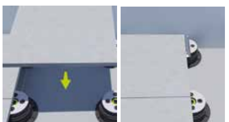
7. Colocar las baldosas.
