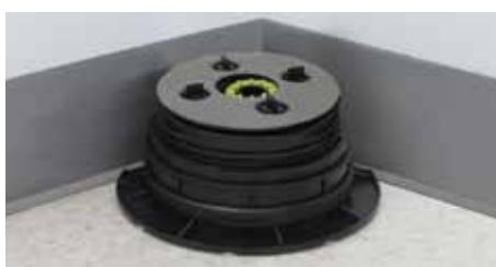
2. Montar el soporte y colocar los dos lados cortados en la esquina.
