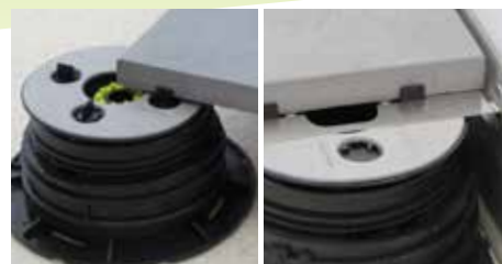
14. Apoye los ángulos de la baldosa entre las aletas apropiadas.
