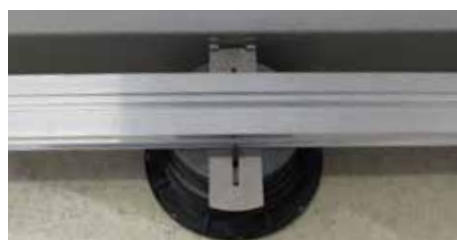
8. Encajar el rastrel entre las aletas SUPA4 de los soportes perimetrales.
