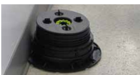
5. Montar el soporte y colocarlo con el lado cortado apoyado en la pared.
