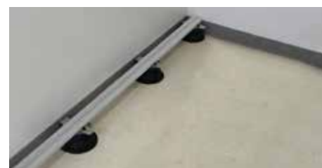
9. Comprobar que el rastrel esté firmemente enganchado a todos los soportes.
