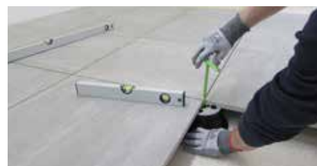
17. En el caso de el pavimento no sea lineal, ajuste la altura con la llave SUPAK.
