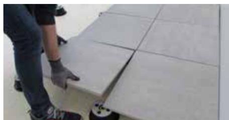
15. Posez les autres carreaux.
