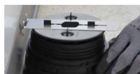
6. Encajar el clip espaciador SUPACLPP entre las dos aletas perpendiculares a la pared.
