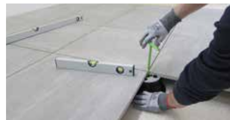
17. En cas de mauvais alignement, réglez la hauteur à l'aide de la clé SUPAK.
