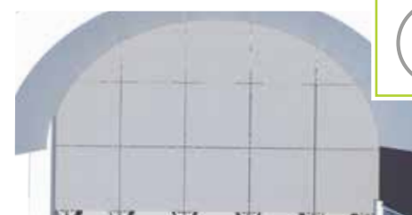
15. Cortar las baldosas de la pared correctamente y colocarlas siguiendo el esquema de colocación.
