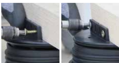
20. Visser le liteau sur le support par les fentes prévues à cet effet (à l'aide d'une visseuse).
